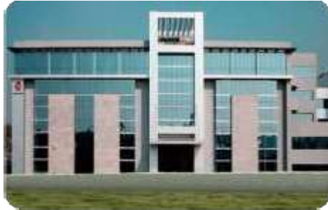
Vodafone Viman Nagar
